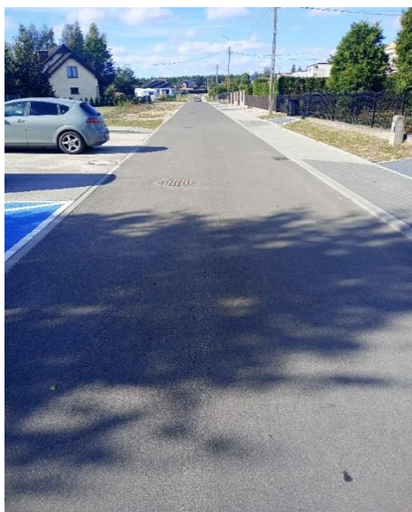
Utwardzenie ulicy Spacerowej
