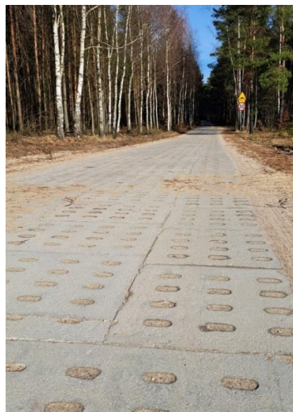
Utwardzenie drogi na odcinku między Cieciorą a Kazubem
