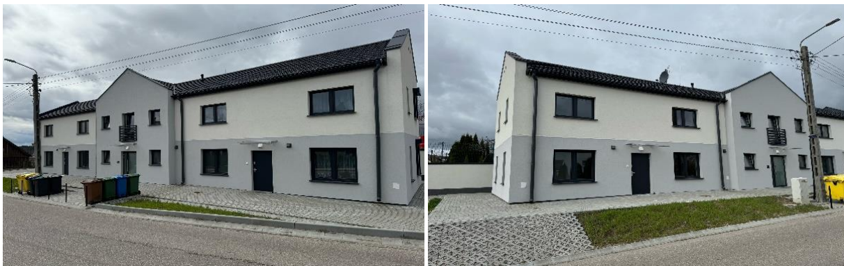
Budynek Komunalny w Piecach
