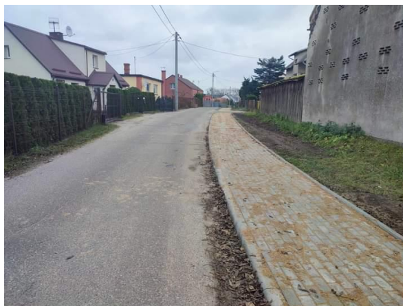
Remont chodnika przy ul. Krzywej
