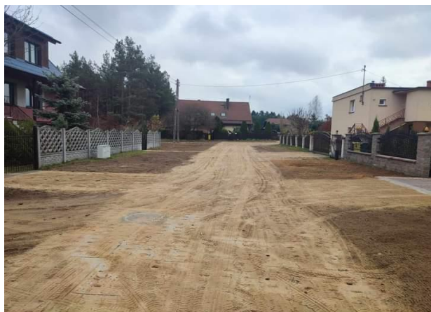
Utwardzenie ul. Okrężnej w Kaliskach
