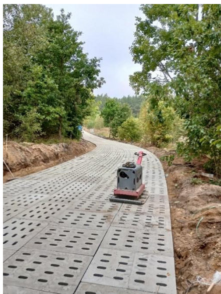
Utwardzenie drogi na odcinku między Dąbrową a Strychem
