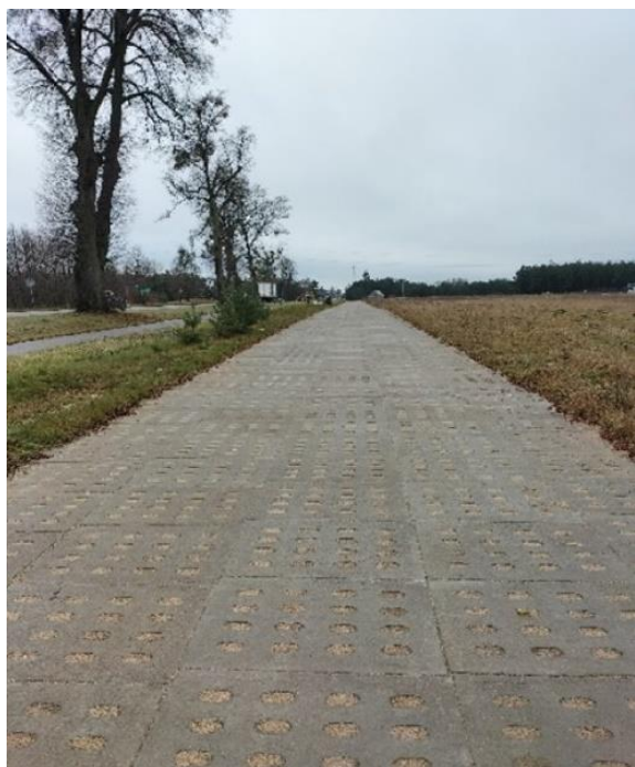
Budowa drogi z płyt jomb na Osiedlu Leśnym w Dąbrowie oraz na odcinku od osiedla do miejscowości Dąbrowa
