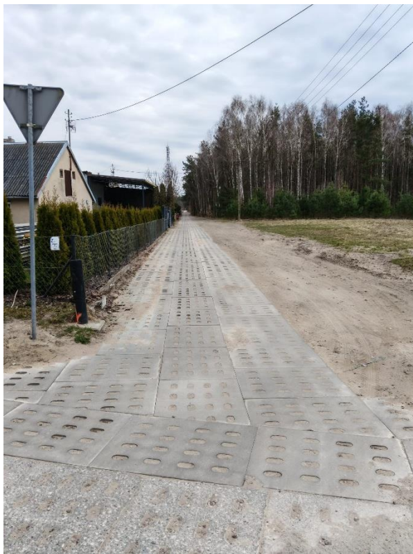
Utwardzenie ulicy Brzozowej we Franku
